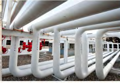
Fabricación de líneas de proceso
