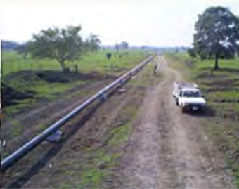
Construcción de líneas de descarga
