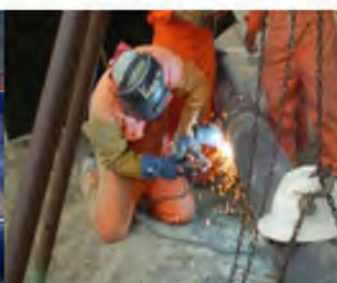
Soldadura calificada en líneas de descarga y gasoductos
