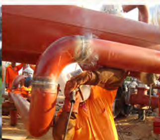
Soldadura calificada en líneas de proceso
