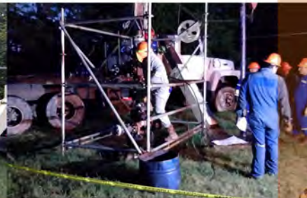
Prueba Hidrostática en línea de bombeo
