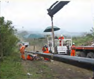
Construcción de gasoductos
