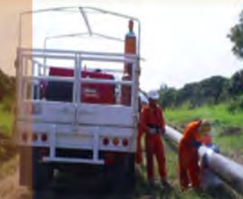
Sustitución de carretes
