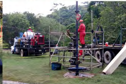
Prueba Hidrostática en líneas de descarga
