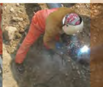
Soldadura en bajas y llegadas de pozo
