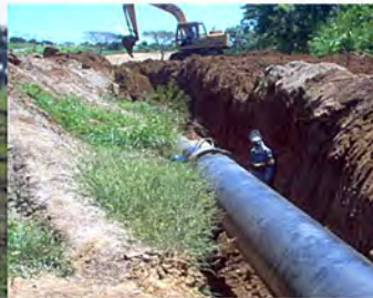
Construcción de oleogasoductos
